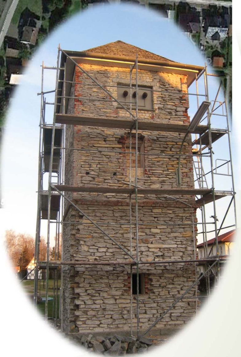
Turmstation Mühlenfeld in der Umbauphase
