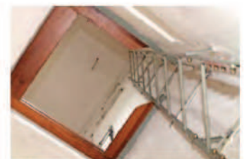
Die künftige Wohnung der Schleiereule ist über eine steile Leiter erreichbar.
