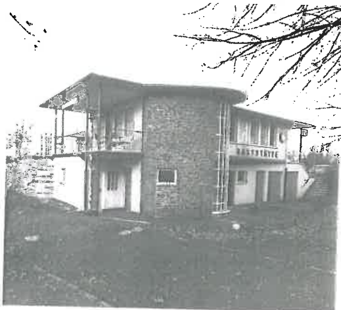
Kassel, Leipziger Straße, erbaut um 1955 (Gaststätte, Kiosk, WC und Trafo)
