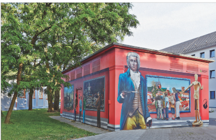
Bild 9: Transformatorstation der Stadtwerke in Schwedt (BB), Berliner Str. 56, Motiv: Kunst- und Musikschule Schwedt Foto: Marco Brzozowski
