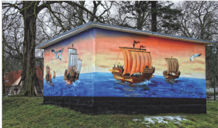
Bild 10: Transformatorstation der E.ON-edis in Ralswiek/Rügen (MV), Motiv: Segelschiffe Foto: Christine Graewer
