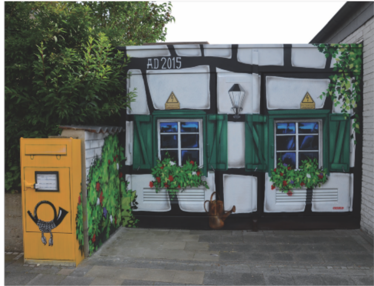
Bild 22: Transformatorstation der RWE Westnetz in Bergheim (NW), Zur Giessener Höhe, Motiv: Gartenhäuschen Foto: Westnetz
