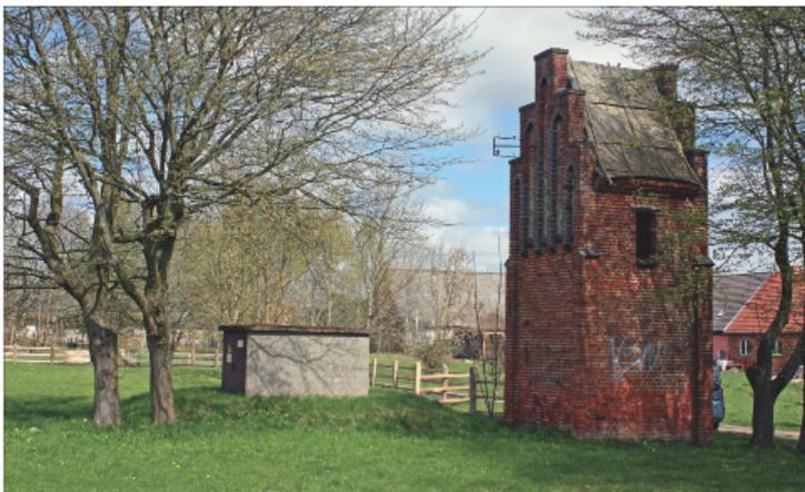
Bild 3: Turmstation im Stil der Backsteingotik mit Ecklisenen in Pinnow, OT Breesen (BB), 1916
