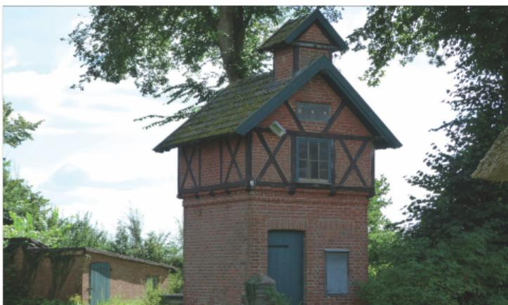
*Bild 13: Turmstation in Backsteinbauweise mit überkragendem Fachwerk im Obergeschoss und zwei abgestuften Satteldächern in Sierksdorf (SH), Stawedder*
