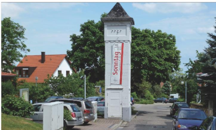
*Bild 12: Turmstation in Betonbauweise mit auffallend schlanker Turmform in Neustadt-Haardt (RP), Am Bürgergarten 5, 1921*
