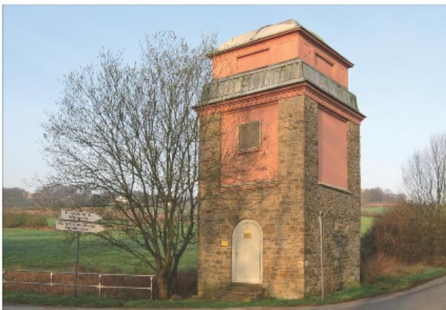
Bild 10: Turmstation aus Bruchsteinmauerwerk mit glockenförmig gestuftem Dach in Wetter-Esborn (NW), Esborner Str. 46, 1922
