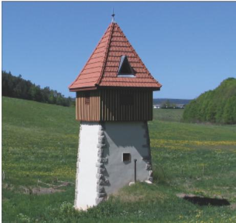
*Bild 18: Turmstation mit pyramidenartigem Unterbau, quadratischem OG mit Brettfassade und steilem Zelt-dach mit Gaube in Meiningen (TH), Landsberger Str.*
