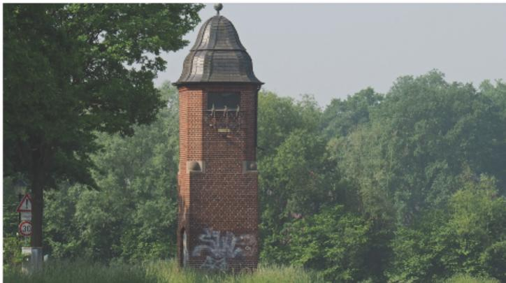
*Bild 11: Turmstation in Backsteinbauweise mit geschweiftem Haubendach auf achteckigem oberem Turmgewölb in Lüdinghausen (NW), Zufahrt Burg Vischering, 1927*
