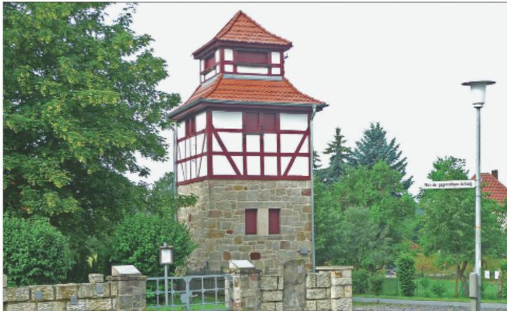
*Bild 5: Turmstation mit pittoreskem Turmaufbau auf kontrastreichem Unterbau mit auf Sandsteinsockel aufgebautem Fachwerk in Volkmarsen (HE), 1922*
