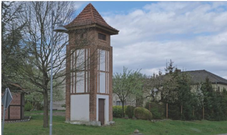
*Bild 17: Turmstation in durch Putzfassaden optisch verschönerter Backsteinbauweise mit leicht abgesetztem Obergeschoss und Zeltdach in Mellin (ST), Am Osterberg*
