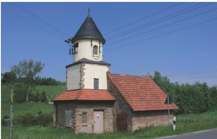
Bild 4: Turmstation mit rundem Turmaufsatz auf zwei abgesetzten quadratischen Turmetagen in Waldeck-Alraft (HE), 1913
