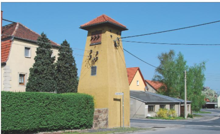
*Bild 15: Turmstation mit sich nach oben verjüngendem quadratischem Turmquerschnitt und überkragendem Satteldach in Moritzburg (SN), Aug.-Bebel-Str., um 1910*
